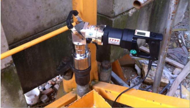
ITH Elektrischer Drehschrauber Typ EDSw an einer Turmstoßverbindung.
