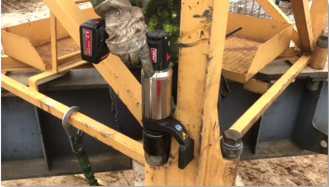
ITH Akku-Drehschrauber Typ ADS 400 an einer Turmstoßverbindung inklusive Sonderabstützung.
