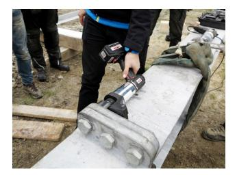
Baustellentauglich und robust: Der Akku-Drehschrauber ITH Typ ADS-150 verschraubt die HV-Schrauben der Stahlträger einer Seilbahn.
