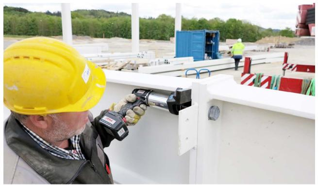
Durch sein neu entwickeltes, mehrstufiges Planetenradgetriebe ist der neue ITH Akku-Drehschrauber Typ ADS der kleinste und leichteste Drehschrauber für hohe Drehmomente bis 4.000 Nm: Hier verschraubte der ITH Typ ADS-150 die HV-Schraubenverbindungen M27 der Stahlträger des neuen Firmenhauptsitzes von ITH Schraubtechnik in Meschede.
